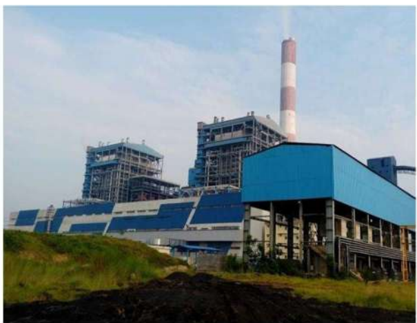
JINDAL THERMAL POWER ANGUL
